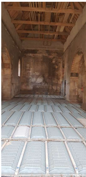
Les hourdis en cours d'installation
