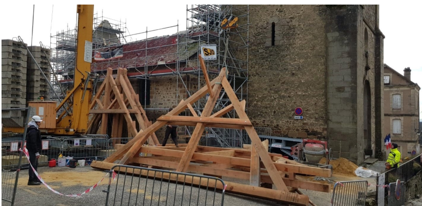
Les éléments de la charpente pré-montés hissés à la grue – 10-11-2021
