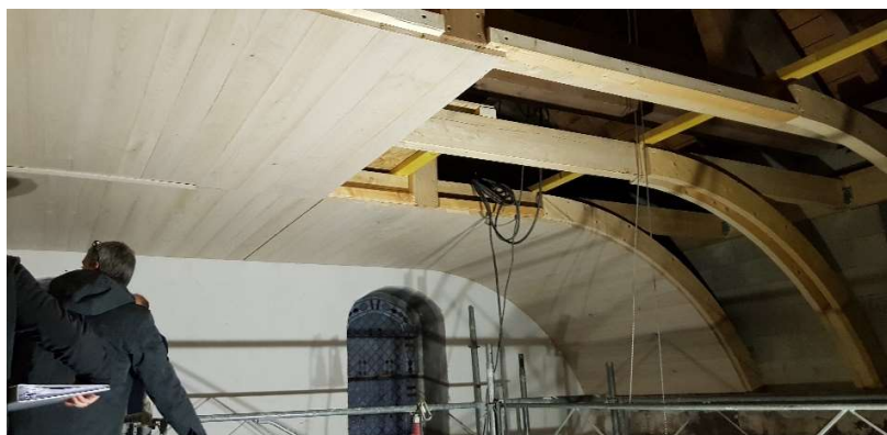
L'installation de la voûte en châtaignier – 11-2022
